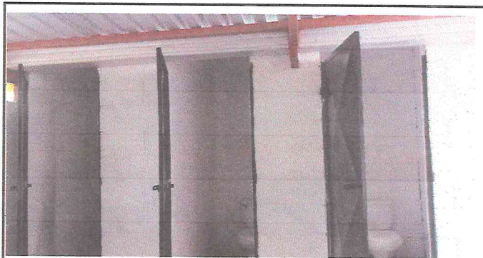
Foto 4: REMOZAMIENTO DE LOS BAÑOS
