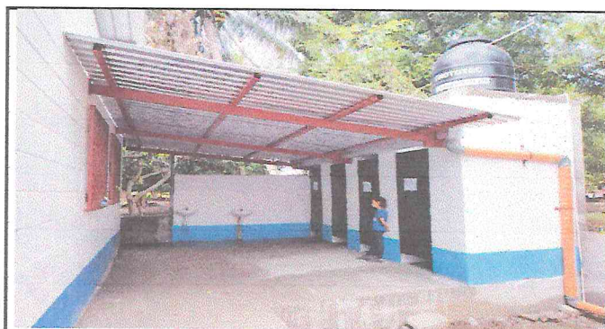
Foto 6: REMOZAMIENTO DE LOS BAÑOS
