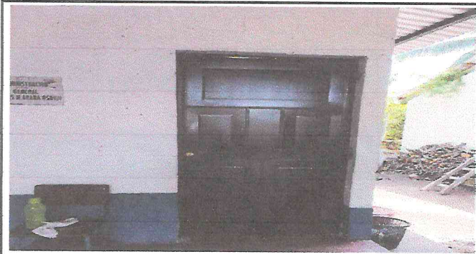
Foto 3: REMOZAMIENTO DE PUERTA
