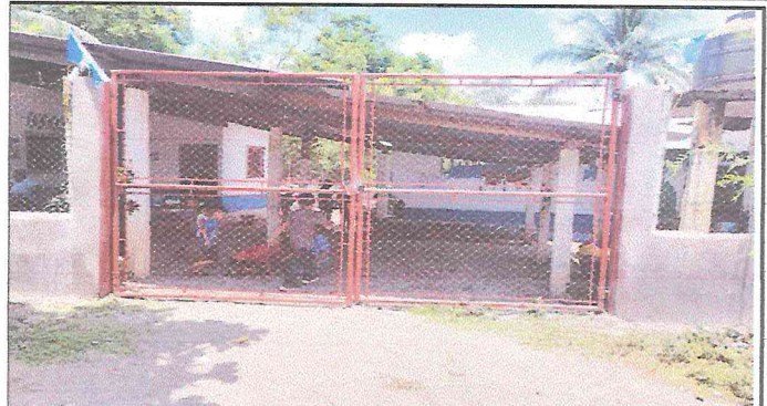
Foto 2: REMOZAMIENTO DE PINTURA DE PORTON
