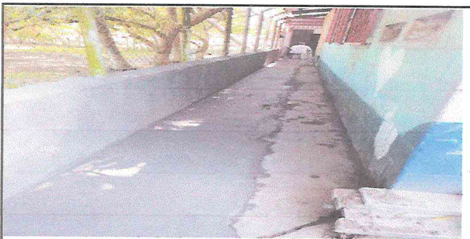
Foto 5: REMOZAMIENTO DE MURO PERIMETRAL
