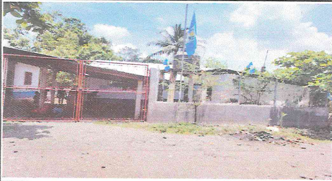
Foto 1: REMOZAMIENTO DE PINTURA DE PORTON
