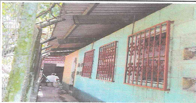
Foto 3: REMOZAMIENTO DE PINTURA DE BALCONES
