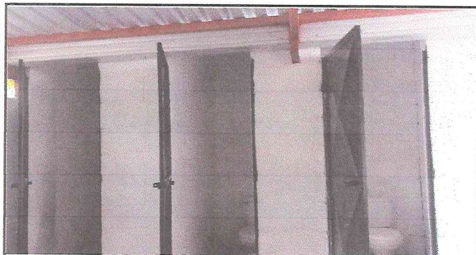
Foto 5: REMOZAMIENTO DE LOS BAÑOS
