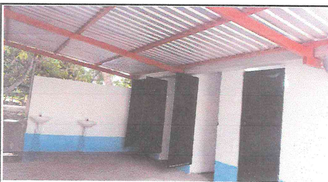
Foto 3: REMOZAMIENTO DE LOS BAÑOS
