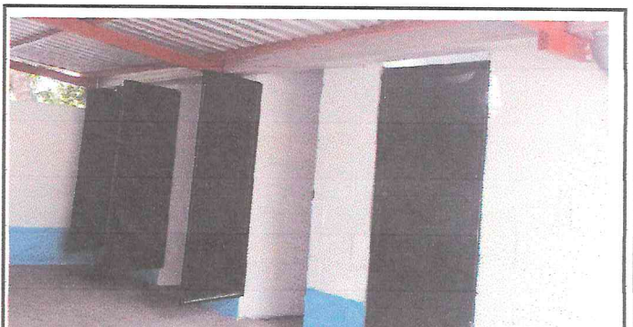
Foto 4: REMOZAMIENTO DE PUERTA
