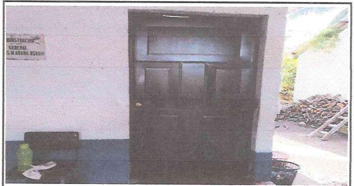
Foto 2: REMOZAMIENTO DE PUERTA
