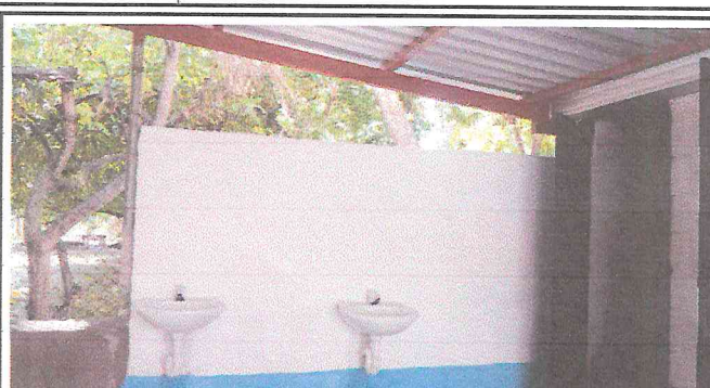
Foto 2: REMOZAMIENTO DE LOS BAÑOS
