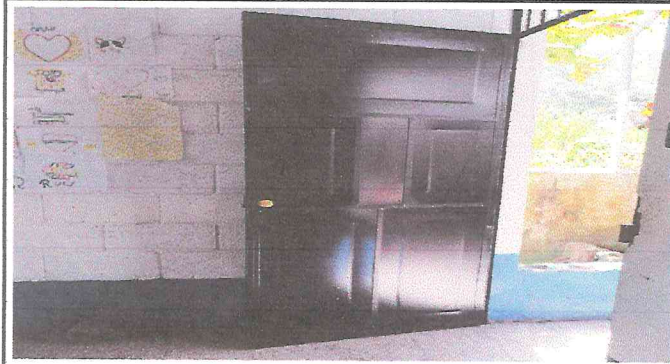
Foto 1: REMOZAMIENTO DE PUERTA
